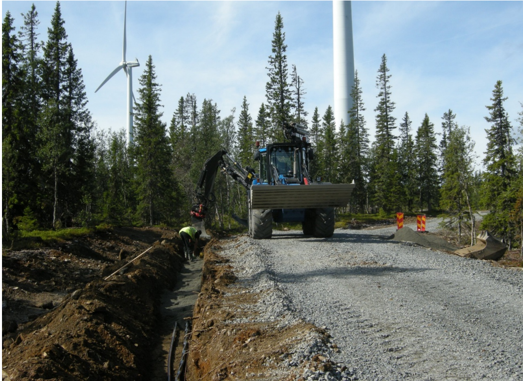
Nedläggning av kabel invid väg.
